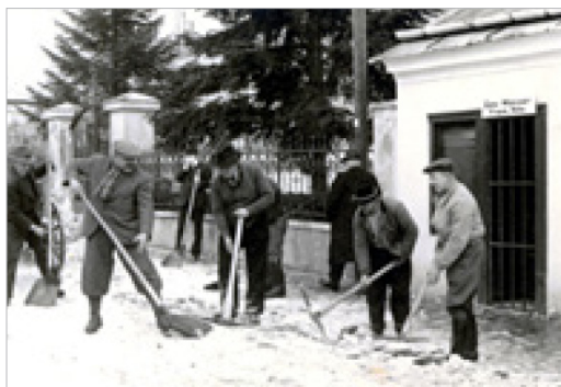
Installateurgeschäft Rille Neustift am Walde 70, im kalten Winter 1940
