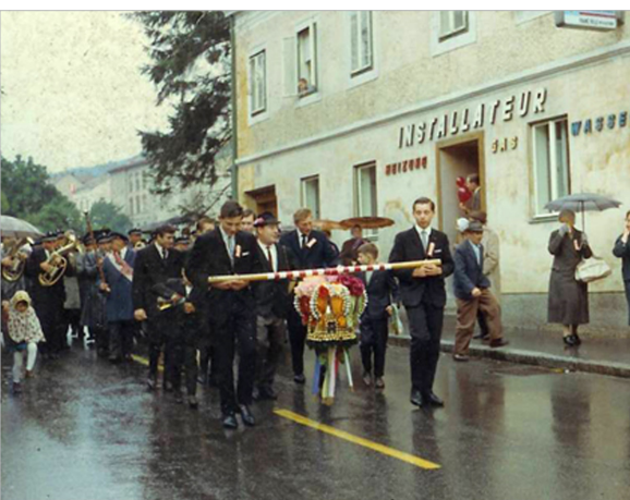
Installateur im ehemaligen Gasthaus
